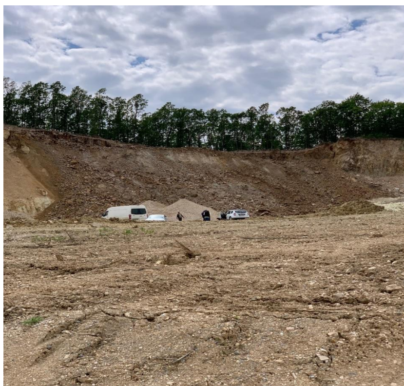
Figură 5. Masivul după detonare
