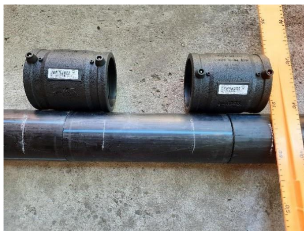
Fig. 5 – Măsurarea și marcarea adâncimii conductei
