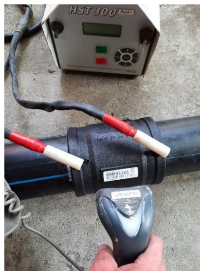
Fig. 6 – Introducerea bornelor și citirea codului de pe mufă
