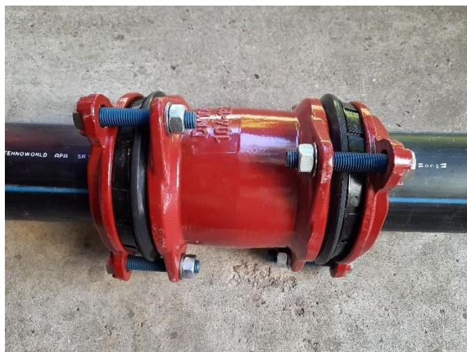
Fig. 10 – Montare finală a mufei rapide pe conductă
