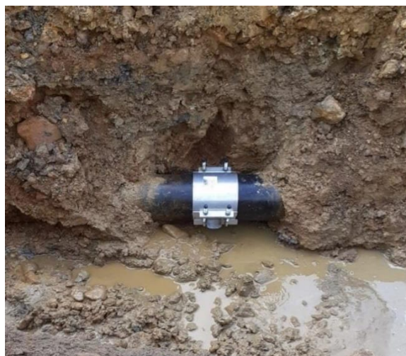
Fig. 3 – Exemplu reparație cu un colier de reparație
