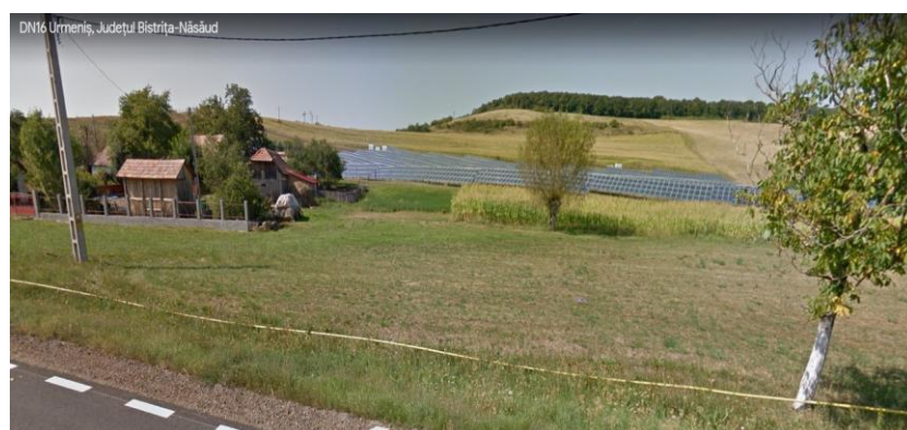
Fig.18 – Parc fotovoltaic Urmeniș, jud. Bistrița Năsăud, vedere stradală
