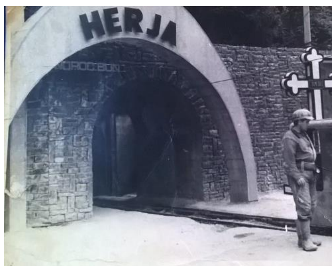
Fig. 4 Tunel Herja – Flotația Centrală
