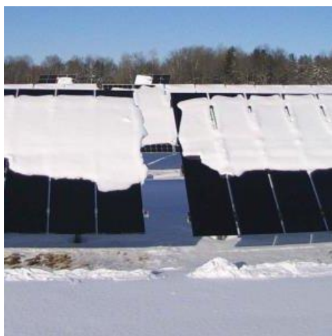
Fig. 2. Module PV acoperite de zăpadă [6]
