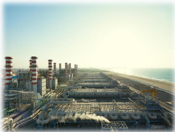
Figura 3.1. Stația de desalinizare Jebel Ali din Dubai
