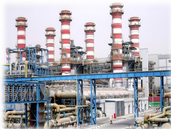
Figura 3.2. Turbine de gaz
