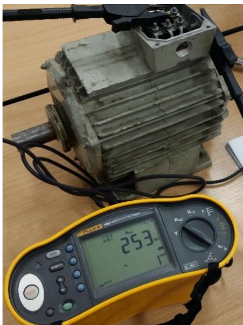
Fig. 2.6. Rezistența de izolație măsurată cu un megohmetru digital.
