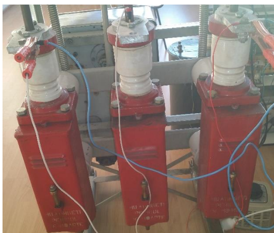
Fig. 3.7. Pregătirea aparatului de încercat pentru măsurarea tangentei de delta cu puntea Schering.
