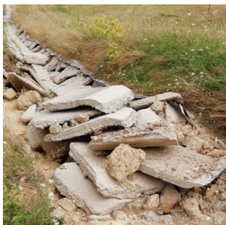
Fig. 14. Șanțul de gardă de la Abrud [6]
