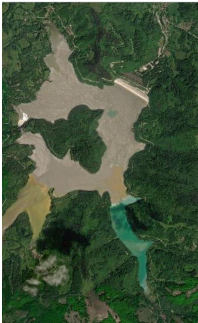
Fig. 5. Vedere din dronă a Iazului Valea Șesii (Imagine preluată din ArcGis)
