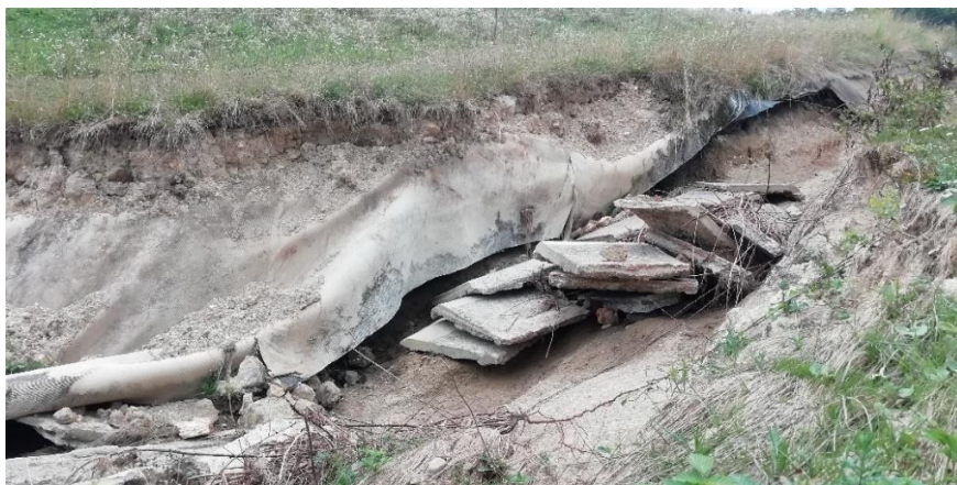
Fig. 15. Șanțul de gardă de la Abrud [6]
